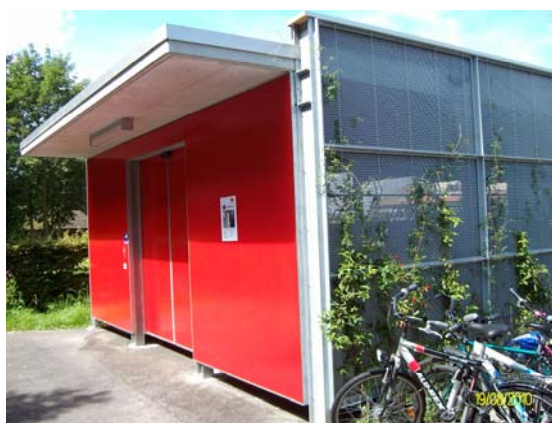
Velohaus: Eingang und begrünte Ostseite mit zusätzlichen prov. Abstellplätzen (© Gemeinde Stein)
